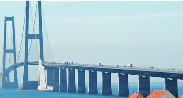
Puente Great Belt Eastern | Storeaelt, Dinamarca | 600 MDD | Gestión de Construcción
