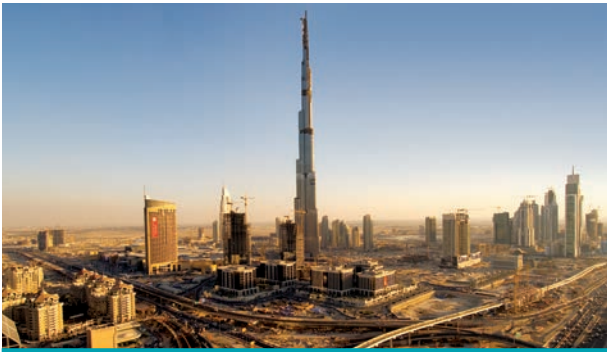
Metro de Dubái | Dubái EAU | 8 MMDD | Gestión de Programa y Gestión de Construcción
