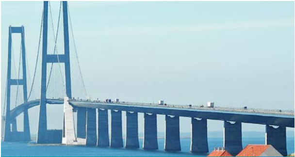
Puente Great Belt Eastern | Storeaelt, Dinamarca | 600 MDD | Gestión de Construcción
