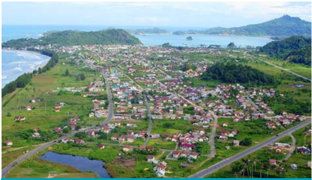
Reconstrucción del Camino/Puente Aceh | Banda Aceh, Indonesia | 282 MDD | Gestión de Diseño y construcción
