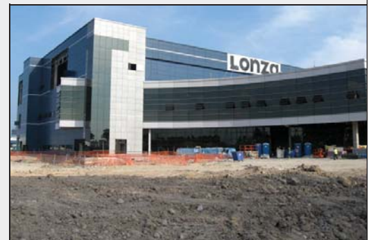
LBXS1 construction site
