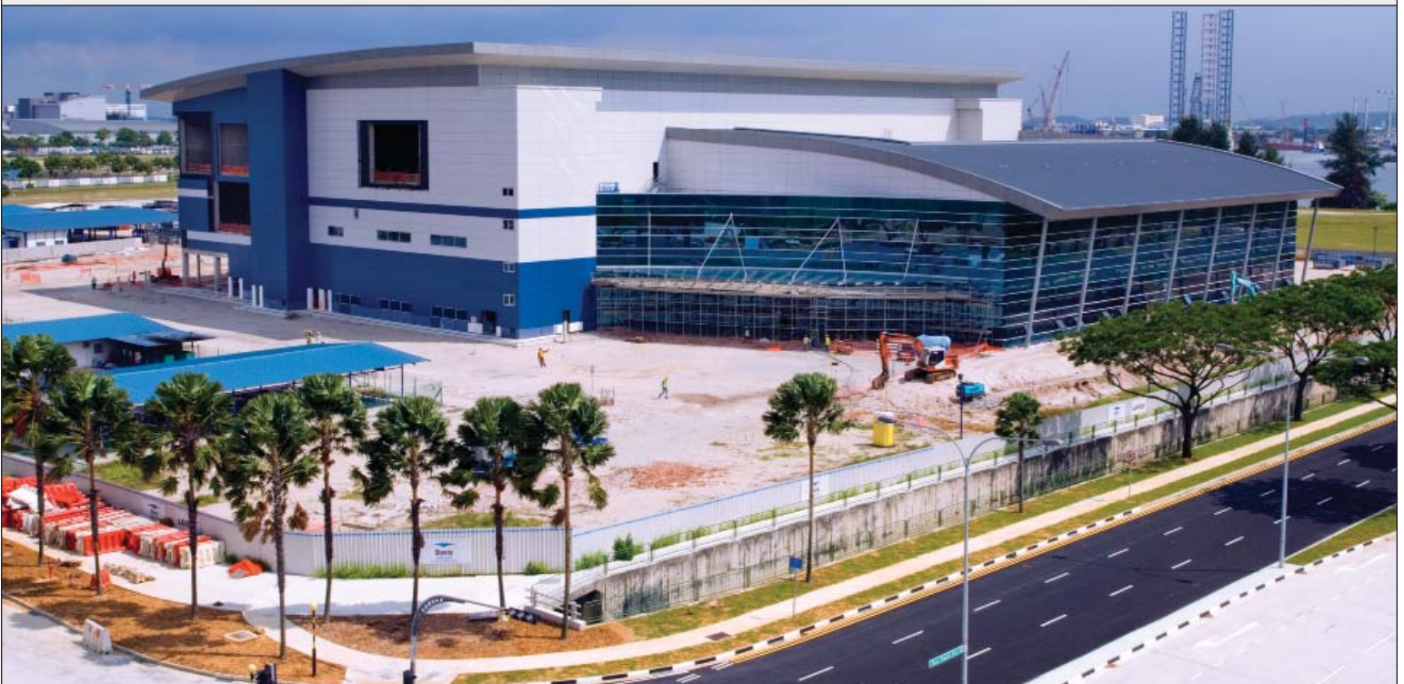
LBXS2 construction site
